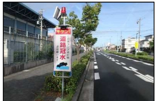
図 道路冠水情報システム
