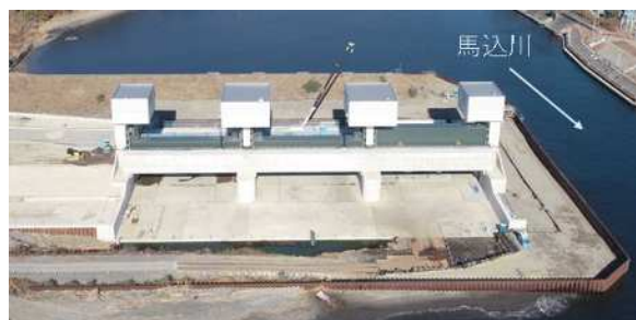
水門整備工事の様子
