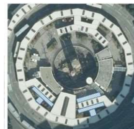
屋根の増設予定箇所 整備箇所： 〇
