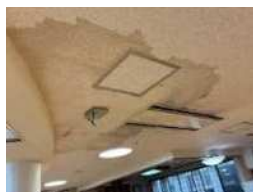
屋根防水更新予定部分
