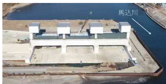
水門整備工事の様子
