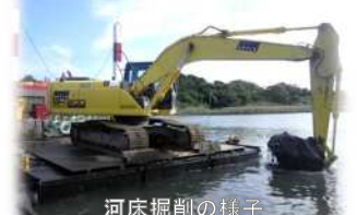
河床掘削の様子
