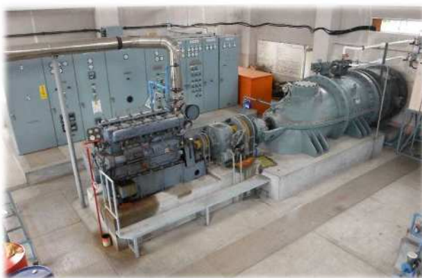
第1排水機場 ポンプ修繕・電気設備更新
