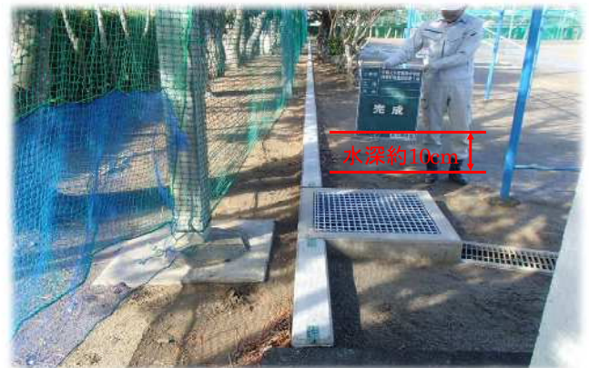
令和元年度施工箇所 (新津中学校)
