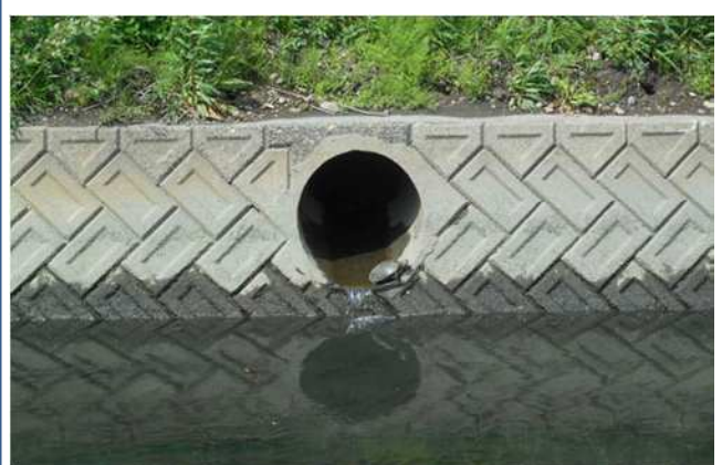
令和2年度現在状況(逆流防止施設)
