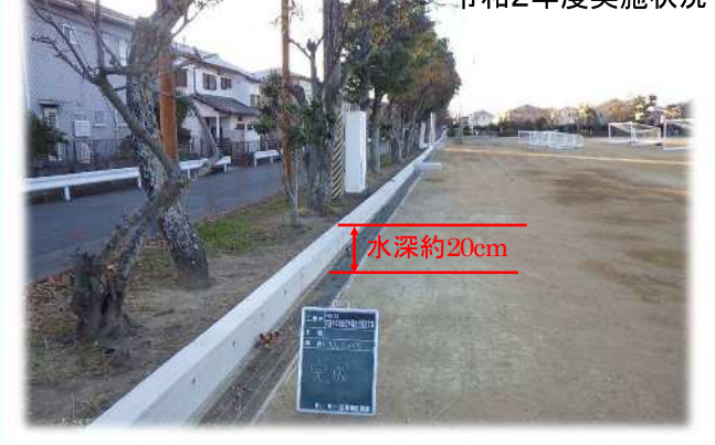
令和2年度施工箇所 (可美中学校)
