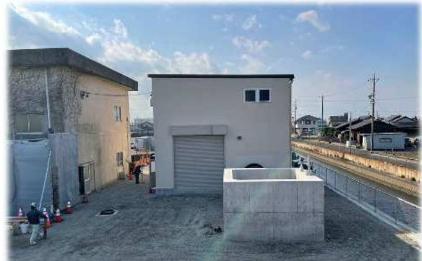
第2排水機場 上屋工及び吐水槽
