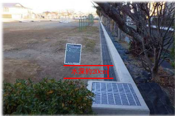
令和2年度施工箇所 (可美中学校)
