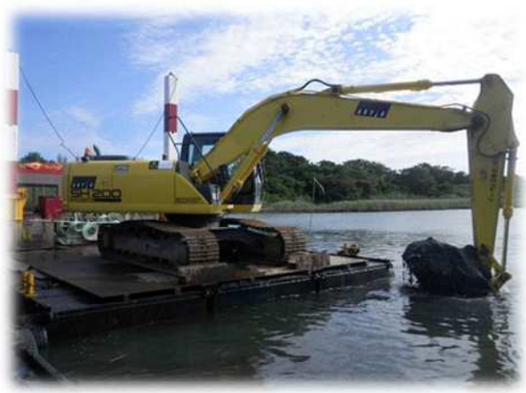
令和1年度 浚渫実施状況
