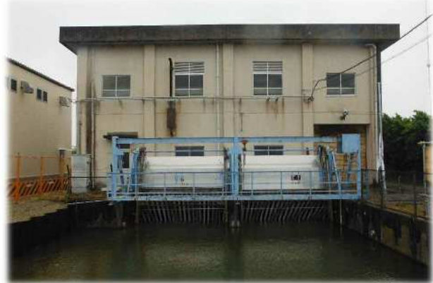
第1排水機場 除塵機更新
