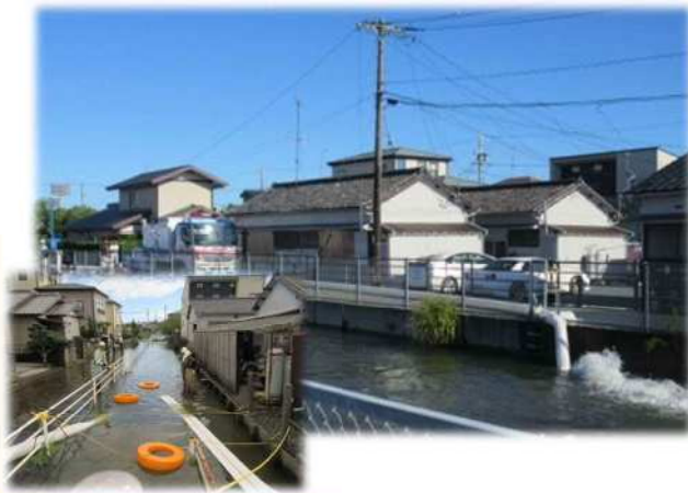
H27年9月の排水ポンプ車設置状況
