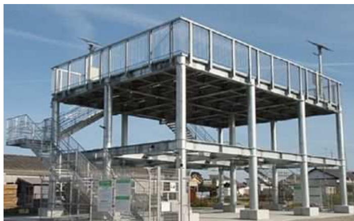
津波避難タワー（中央区三新町）
