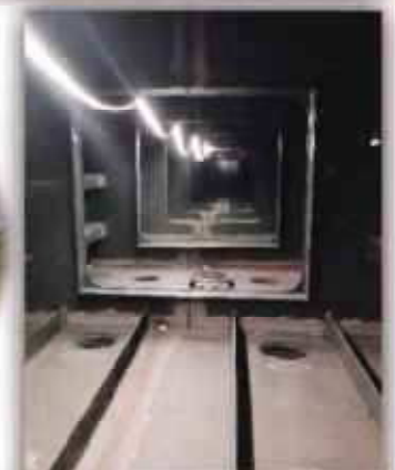
扉体内部の様子
