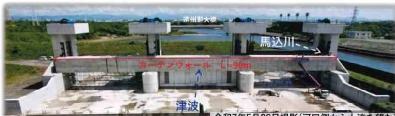
令和7年5月28日撮影(河口側から上流を望む)
