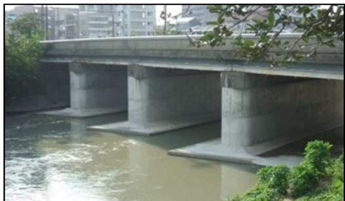
図 橋梁の耐震補強の事例 【基本方針3(1) 緊急輸送路の沿道建物や橋梁の耐震化等による道路ネットワーク寸断の防止等】
