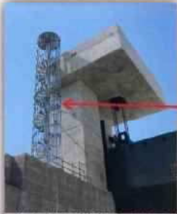
螺旋階段(左)設置完了
