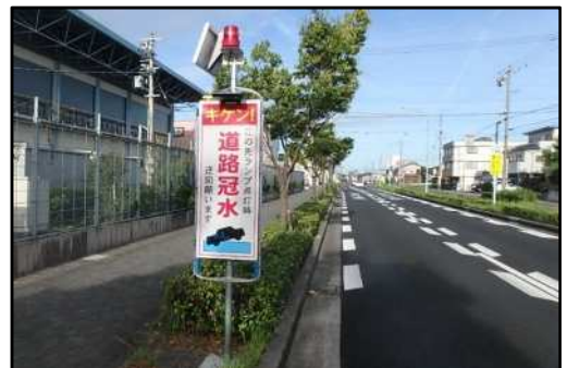
図 道路冠水情報システム
