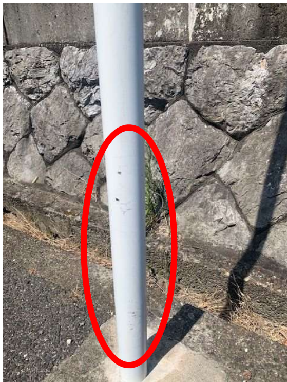
交通標識には、10cm程度の塗装の剥がれとこすり傷
