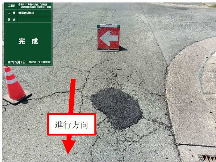
仮復旧後（北側から撮影）
