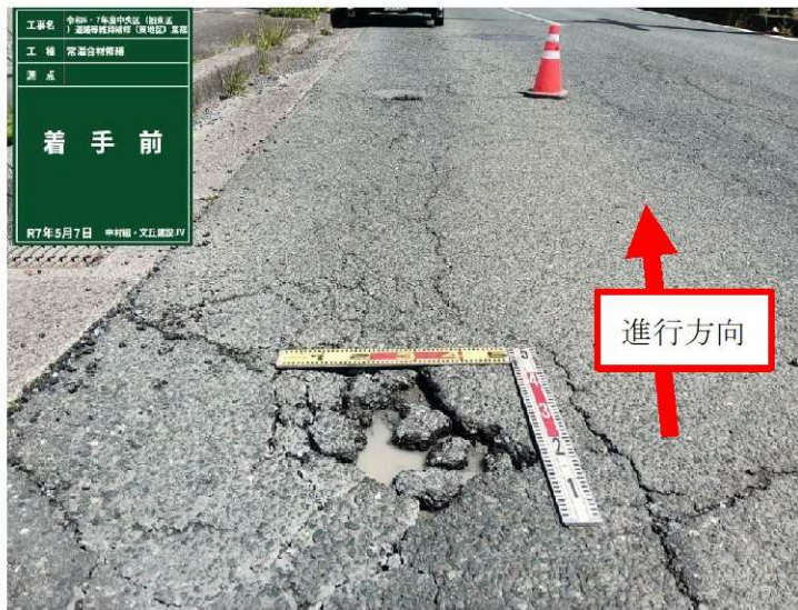
市道小池三島線（南側から撮影）
