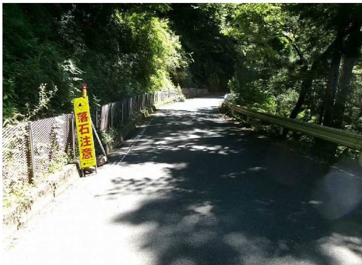
一般県道水窪森線 注意喚起看板設置後（西側から撮影）
