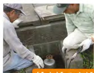
給水栓の点検
