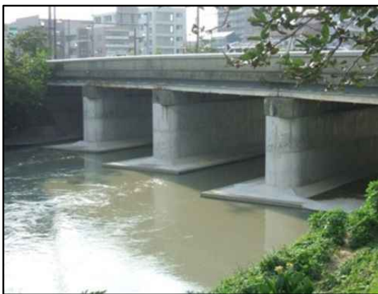
図 橋梁の耐震補強の事例
