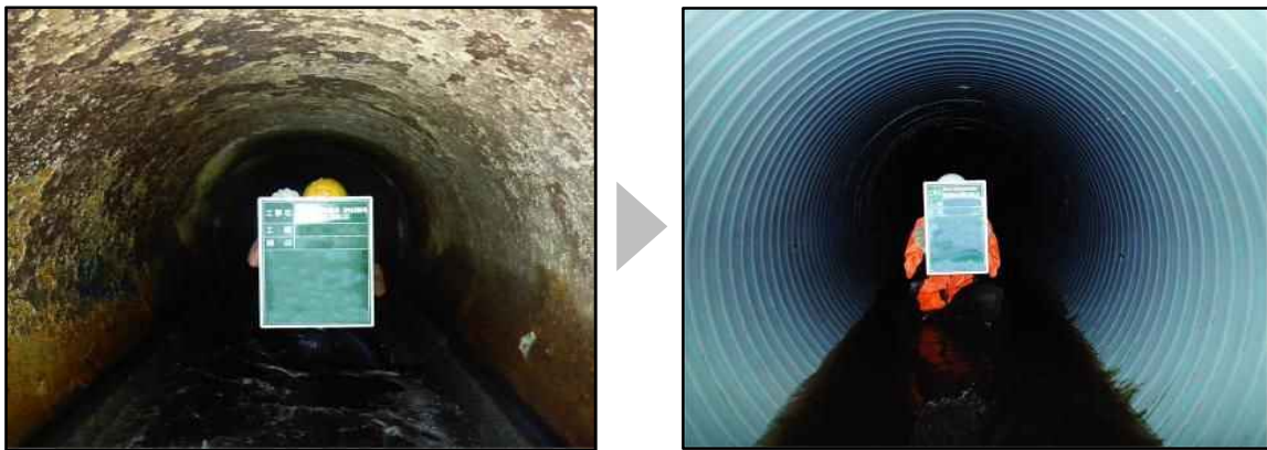
図 下水道施設の耐震化の事例
