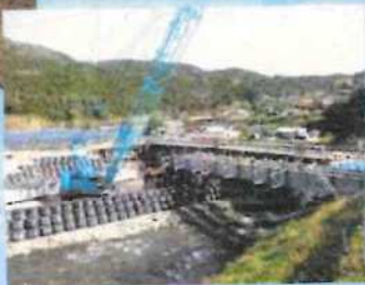
200tクレーンによる 上部工架設▶
