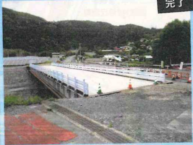
令和7年5月設置完了
