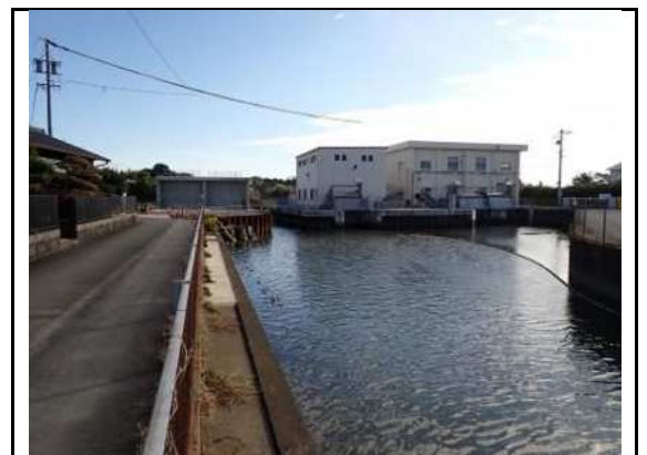
図 排水機場（高塚川）
