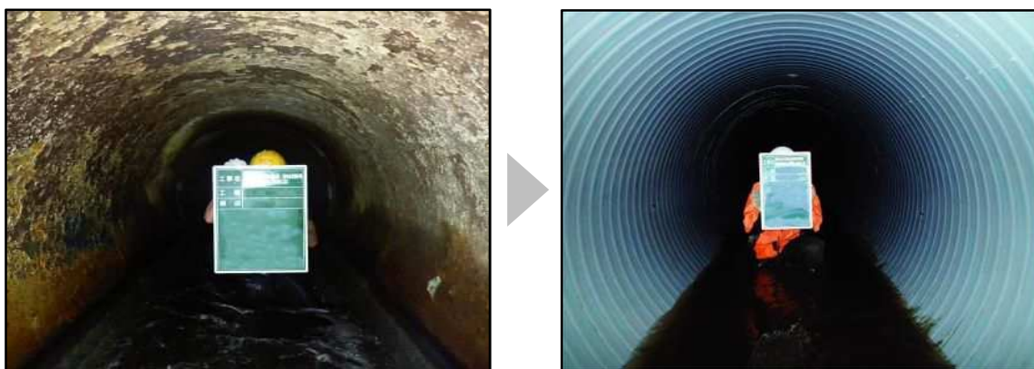
図 下水道施設の耐震化の事例
