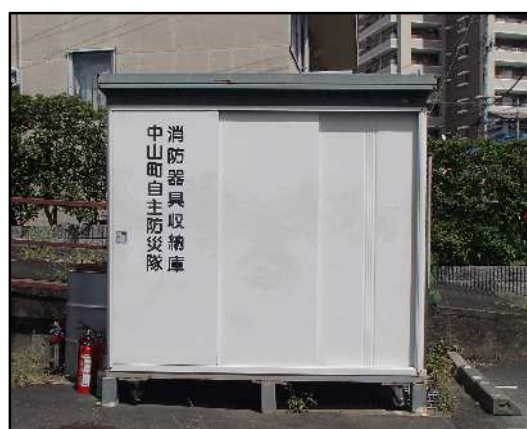
図 地域の消防器具収納庫
