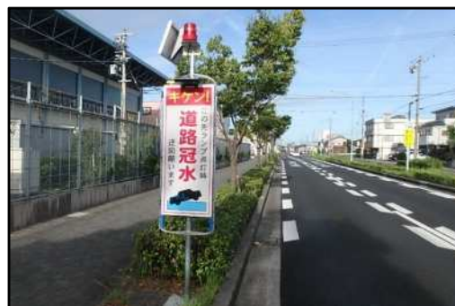
図 道路冠水情報システム
