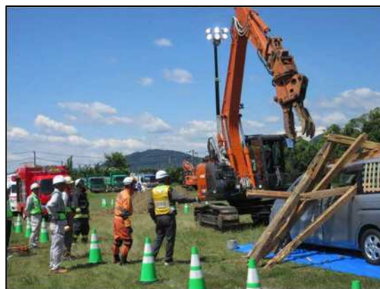
図 道路啓開実働訓練の様子
