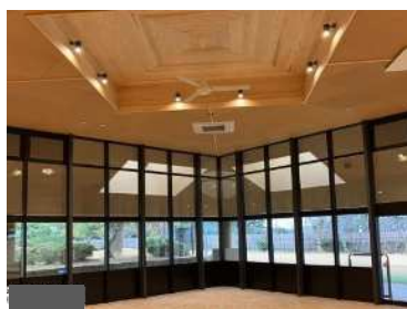
完成後(ホール)
