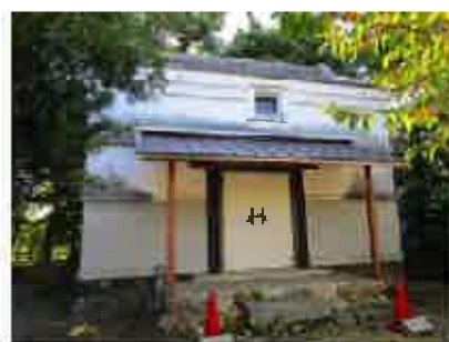
▲中村家住宅土蔵の改修
