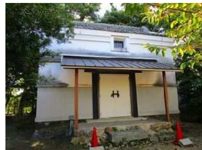
▲中村家住宅土蔵の改修
