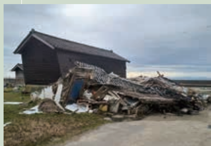
能登半島地震で倒壊した家屋
