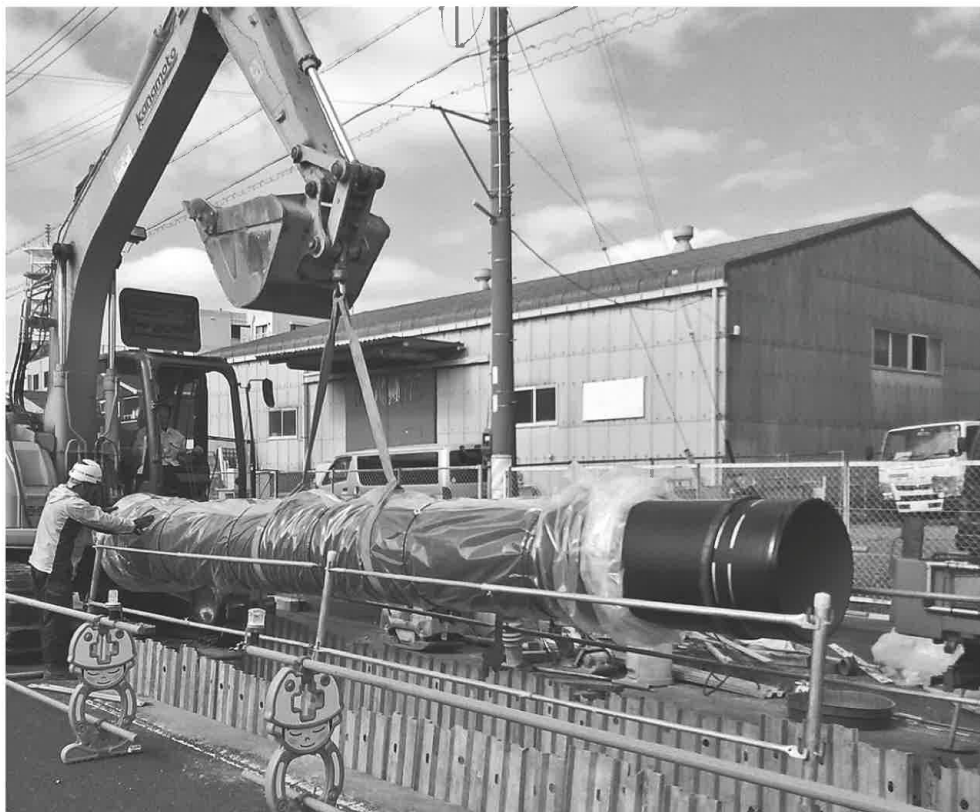
直径60cm、重さおよそ1tの水道管を、深さ1.2mの地中に埋設する工事現場。 重機で水道管を吊り上げながら、慎重に作業を進めます(中央区植松町)
