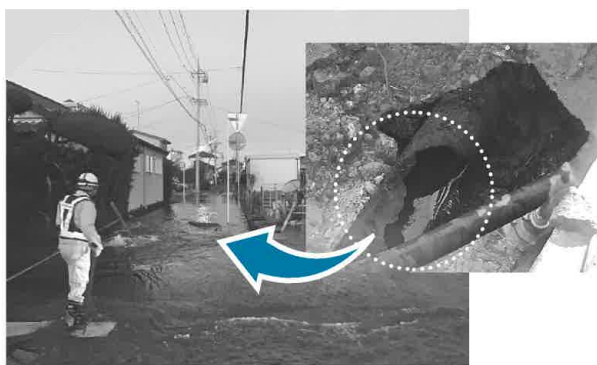
2024（令和6）年度に発生した、水道管の老朽化が原因の漏水（中央区東若林町）
