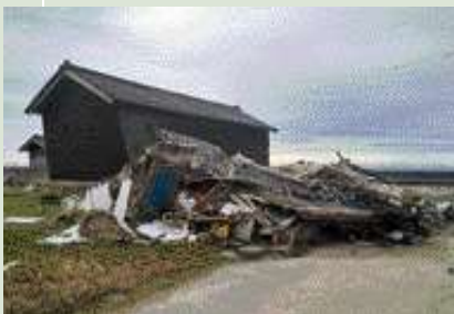
能登半島地震で倒壊した家屋
