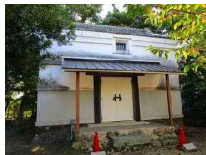
▲中村家住宅土蔵の改修
