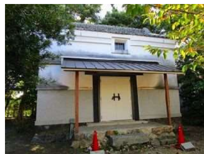
▲中村家住宅土蔵の改修
