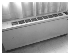
ファンコイルユニット
