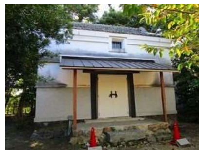
▲中村家住宅土蔵の改修
