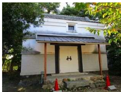
▲中村家住宅土蔵の改修
