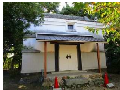
▲中村家住宅土蔵の改修
