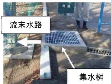
雨水流出抑制施設の例
