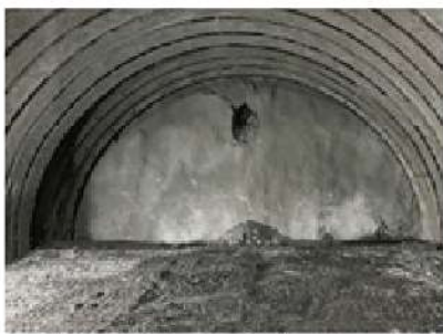
青崩峠トンネル（仮称）貫通 提供 国土交通省飯田国道事務所
