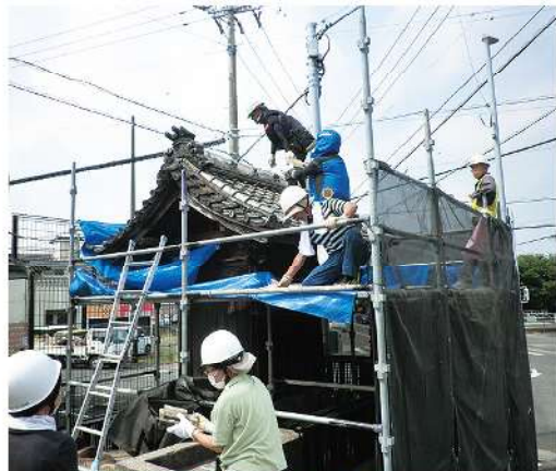
修理工事の瓦はずし作業
