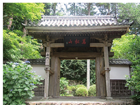
龍潭寺山門(修理前)
