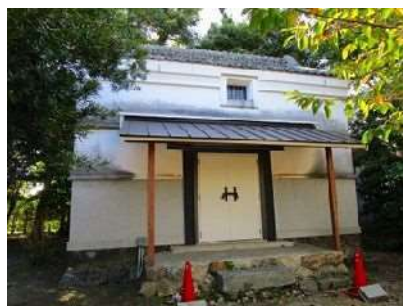
▲中村家住宅土蔵の改修
