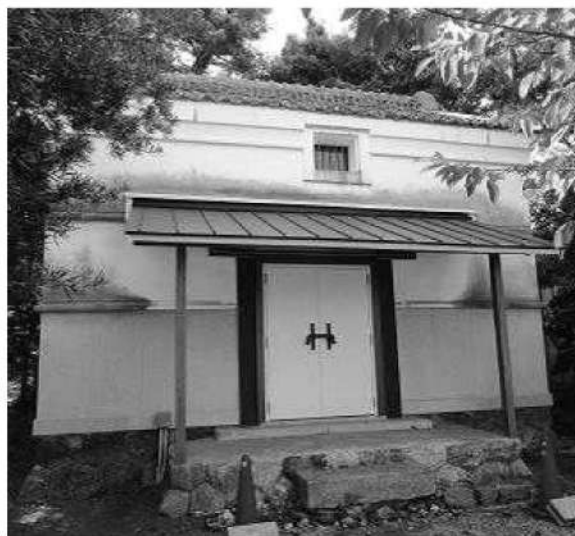
土蔵建物の外観
