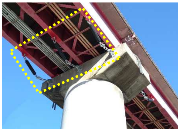
【橋りょう耐震補強事業 落橋防止装置設置状況】
