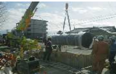
耐震管への布設替えによる水道基幹管路の耐震化
