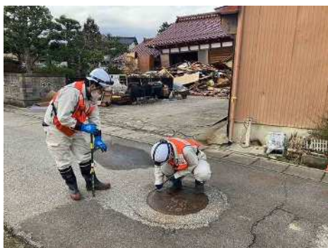
令和6年能登半島地震における復旧活動 （被害調査）[石川県珠洲市]
