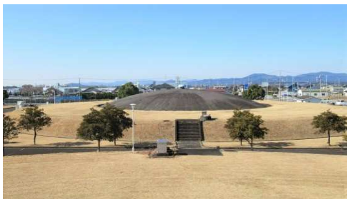
再構築に向けて稼働を停止した大原浄水場の第 2 配水池 (2024 年度に稼働停止)
