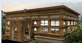
① 旧住吉浄水場 ポンプ室の 3次元点群データ化
