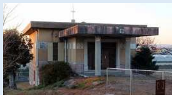
旧常光水源地 ポンプ室
