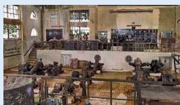
① 旧住吉浄水場 ポンプ室の 3次元点群データ化
