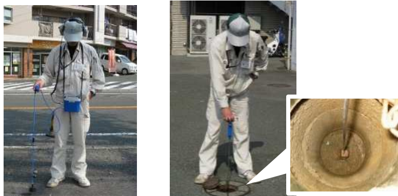
漏水探知機（左）と音聴棒（右）による漏水調査
