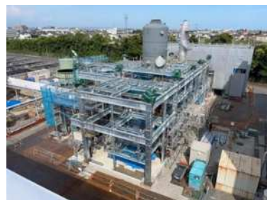
エネルギー効率の高い污泥焼却炉への更新工事 (2022～2024年度) [中部浄化センター]
