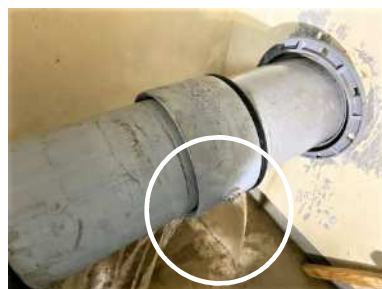
施設内配管からの漏水による配水ポンプの水没 (2022 年度) [湖東配水場]
