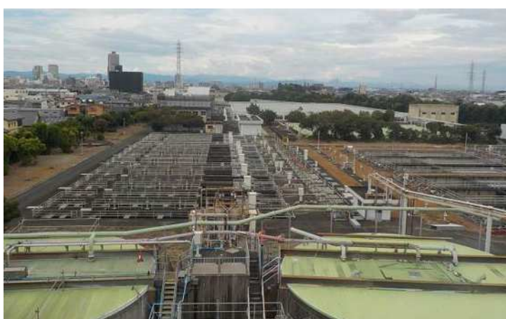
供用開始から 58 年経過した中部浄化センター [中央区瓜内町]
