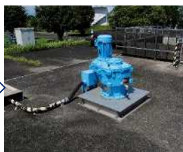
小型でエネルギー効率の高い急速攪拌機への更新 (2022年度) [大原浄水場]
