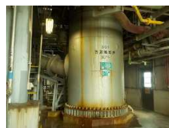
汚泥焼却炉 [中部浄化センター]
