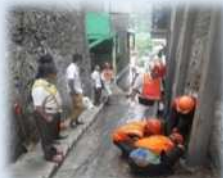
漏水工事の状況確認 （2017 年度 バンドン市）
