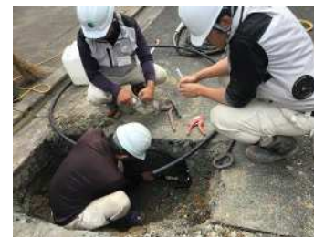
OJT（管路修繕）
