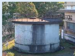
旧住吉浄水場 直送ポンプ井
