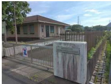
都田地区農業集落排水処理施設
