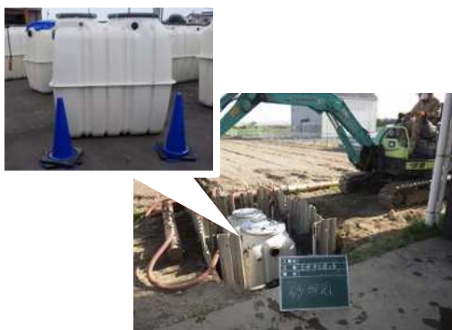
合併処理浄化槽の設置
