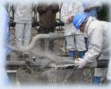
漏水修繕工事の研修 （2017 年度 浜松市）
