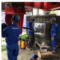
水管橋の耐震化工事（2022年度） 〔常光浄水場〕
