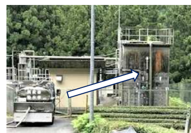
給水車から配水池への補水
