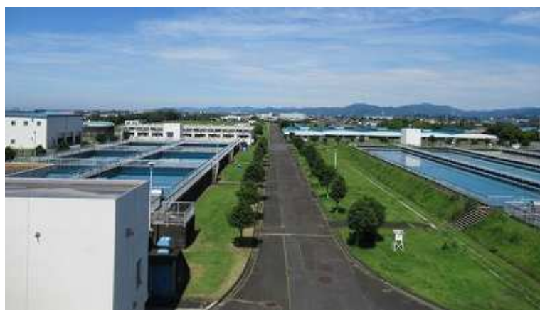
供用開始から 56 年経過した大原浄水場 [中央区大原町]
