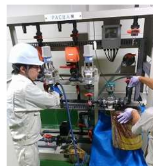
薬品注入機の修繕 [常光浄水場]
