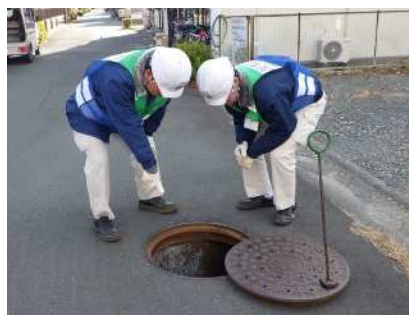
職員による目視点検 (自主点検)
