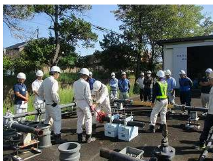
漏水修繕研修 [住吉庁舎の研修施設]
