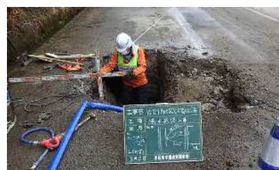
令和 6 年能登半島地震における 本市の事業者による復旧活動 （漏水修繕）[石川県珠洲市]
