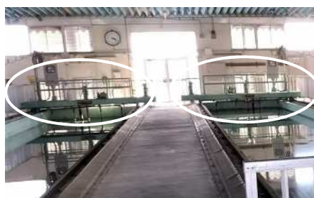
更新予定のろ過池走行台（ろ過池の逆洗用設備） [大原浄水場（左）・常光浄水場（右）]
