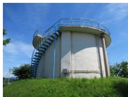
大原浄水場の供用開始当時から稼働している養水井
