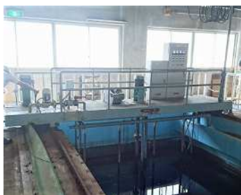
更新予定のろ過池走行台（ろ過池の逆洗用設備） [大原浄水場（左）・常光浄水場（右）]
