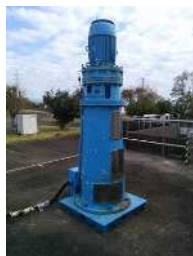
小型でエネルギー効率の高い急速攪拌機への更新 (2022年度) [大原浄水場]
