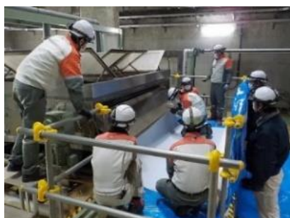
本市によるモニタリング (運営権者が行う点検作業の確認) 〔現地モニタリング〕
