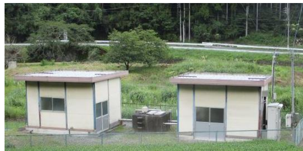
濁水対策のため、水源施設の整備や水融通などを検討している中山間地域の浄水場
