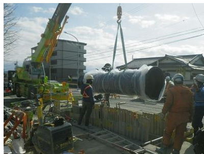
耐震管への布設替えによる 水道基幹管路の耐震化
