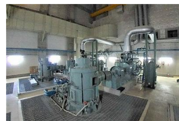
修繕予定の汚泥脱水設備 [三ヶ日浄化センター]
