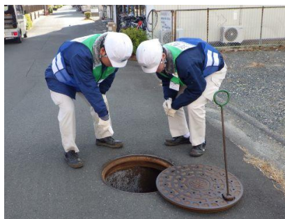
職員による目視点検 （自主点検）
