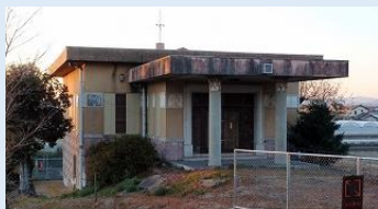
旧常光水源地 ポンプ室
