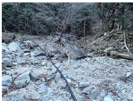
濁水で流入量が減少した水源（沢） ※通常時は水の流入あり (2024年度) [天竜区水窪町]
