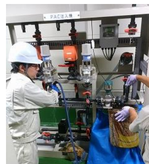
薬品注入機の修繕 [常光浄水場]
