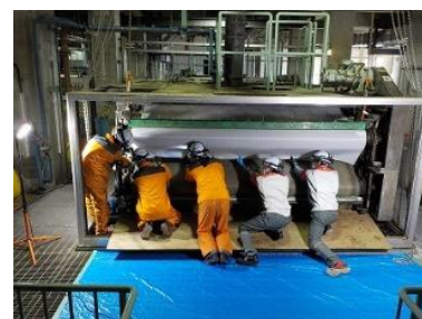
運営権者による自社修繕（脱水機のろ布修繕） 浜松ウォーターシンフォニー㈱提供
