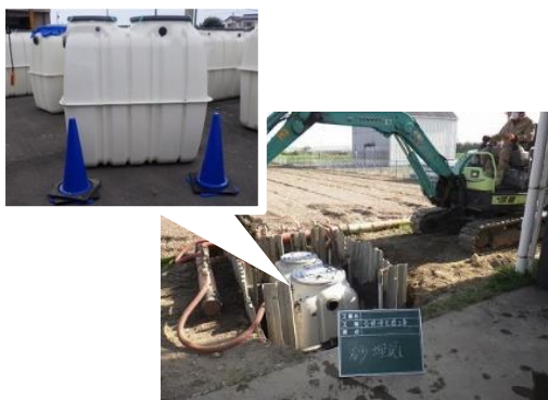
合併処理浄化槽の設置
