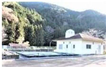
上市場農業集落排水処理施設
