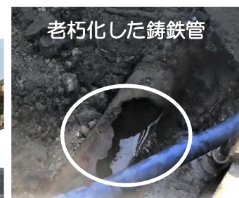
水道管路の老朽化に起因する漏水 (2024年度) [中央区東若林町]
