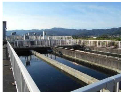
耐震化予定の污泥処理棟（左）と最終沈殿池（右） [細江浄化センター]
