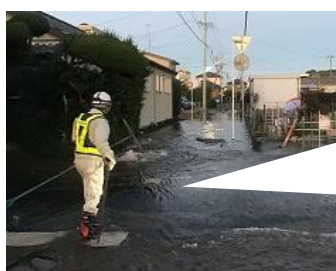
水道管路の老朽化に起因する漏水 (2024年度) [中央区東若林町]
