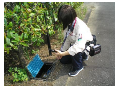
検針員による水道メーターの検針
