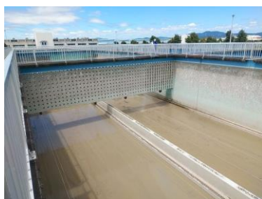
耐震化予定の沈殿池 〔大原浄水場（2系）〕 ※写真は水を抜いた状態
