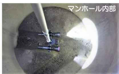
管口カメラによる 下水道管路の内部点検 （法定点検）
