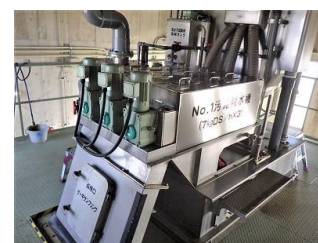
修繕予定の汚泥脱水設備 [三ヶ日浄化センター]
