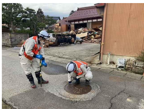
令和6年能登半島地震における復旧活動 （被害調査）[石川県珠洲市]
