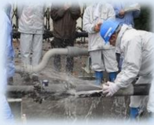
漏水修繕工事の研修 （2017 年度 浜松市）
