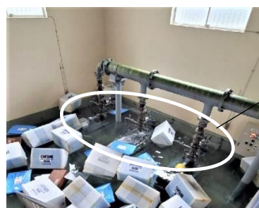
施設内配管からの漏水による配水ポンプの水没 （2022 年度）[湖東配水場]
