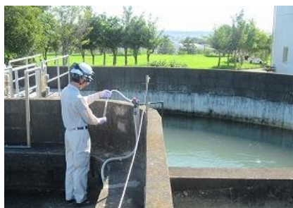
pH調整用硫酸注入設備の導入に向けた実証実験 (2024年度) [大原浄水場]
