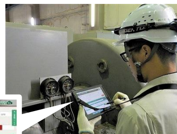
タブレットを使用した施設情報システムによる設備の状態把握 [中部浄化センター]
