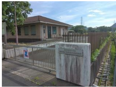
都田地区農業集落排水処理施設
