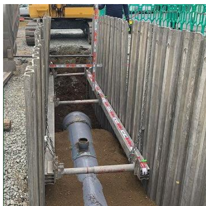
下水道の整備
