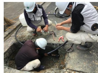
OJT（管路修繕）
