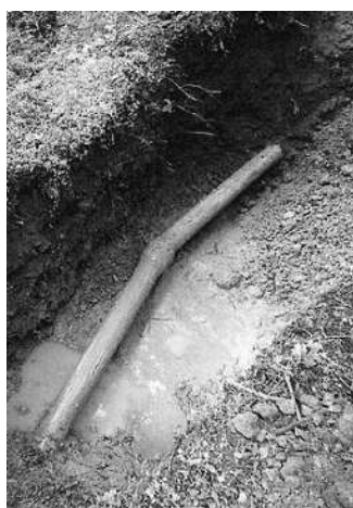
飲料水供給施設の管路修繕(着手前)
