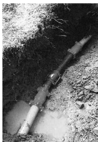
飲料水供給施設の管路修繕(完成)
