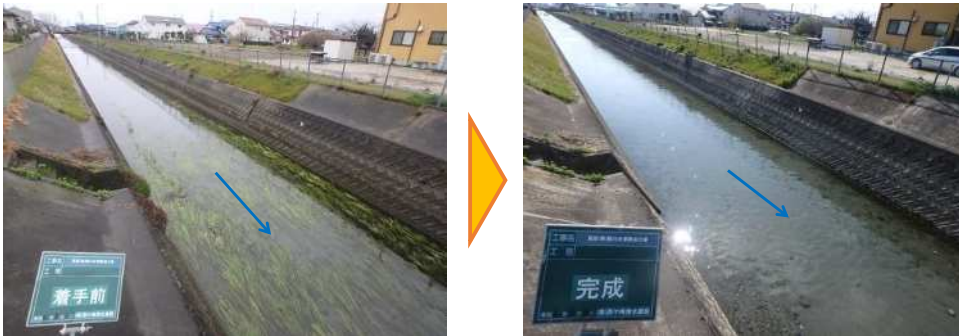
写真 河道の維持管理を行った事例
