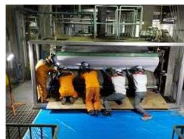
運営権者による自社修繕（脱水機のろ布修繕） 浜松ウォーターシンフォニー(株)提供
