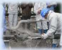
漏水修繕工事の研修 (2017 年度 浜松市)
