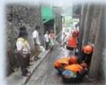
漏水工事の状況確認 (2017 年度 バンドン市)
