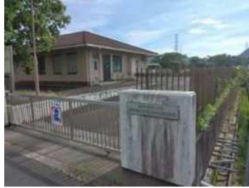
都田地区農業集落排水処理施設
