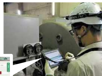
タブレットを使用した施設情報システムによる設備の状態把握 〔中部浄化センター〕
