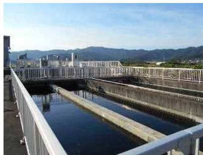
耐震化予定の汚泥処理棟（左）と最終沈殿池（右） [細江浄化センター]
