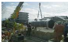
耐震管への布設替えによる水道基幹管路の耐震化
