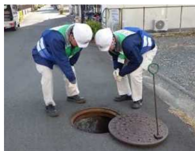
職員による目視点検 （自主点検）
