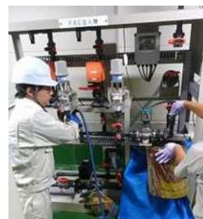
薬品注入機の修繕 [常光浄水場]
