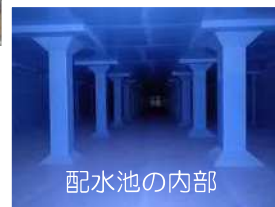
耐震性を有する配水池の整備 （2013年度）〔大原浄水場 第5配水池〕
