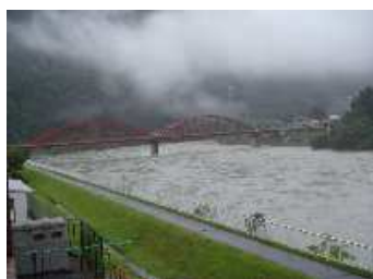
大雨（令和2年7月豪雨）により増水した天竜川
