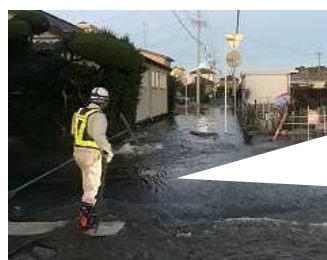
水道管路の老朽化に起因する漏水 (2024年度) [中央区東若林町]
