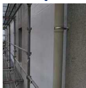
開口部閉塞によるポンプ場の耐震化 （2020 年度）[中田島団地雨水ポンプ場]
