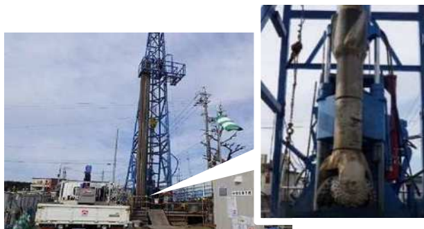
新規井戸水源施設の整備に向けた試験掘削工事 (2021 年度) [中央区半田町]
