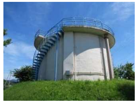
大原浄水場の供用開始当時から 稼働している着水井
