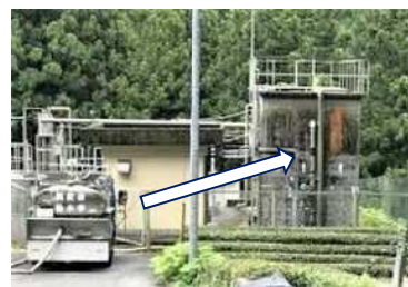
給水車から配水池への補水
