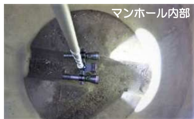
管口カメラによる 下水道管路の内部点検 （法定点検）
