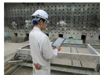
タブレットを用いた日常点検 [大原浄水場]
