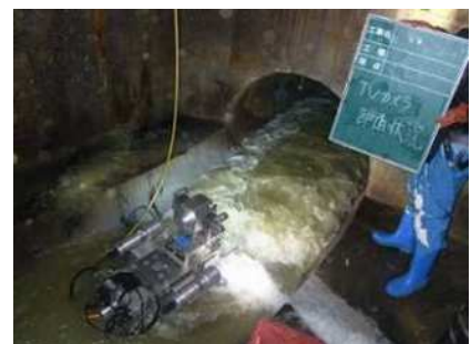
テレビカメラ車による 下水道管路の内部調査
