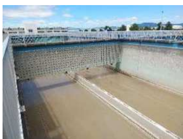
耐震化予定の沈殿池 〔大原浄水場（2系）〕 ※写真は水を抜いた状態
