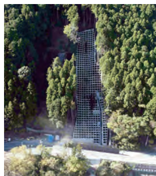
国道152号災害復旧工事（完成） （天竜区龍山町）
