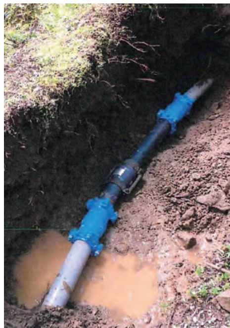
飲料水供給施設の管路修繕（完成）
