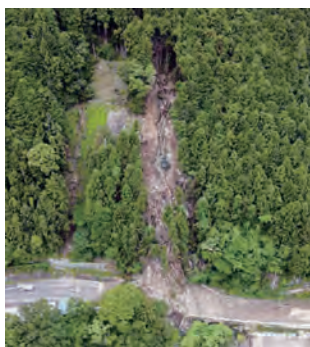
国道152号災害復旧工事（着手前）
