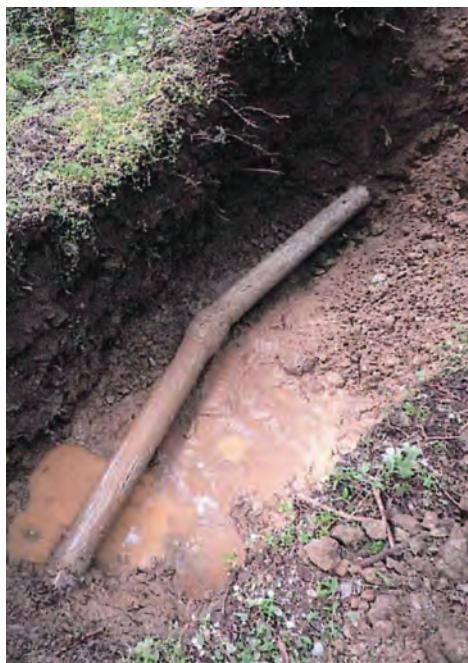
飲料水供給施設の管路修繕（着手前）
