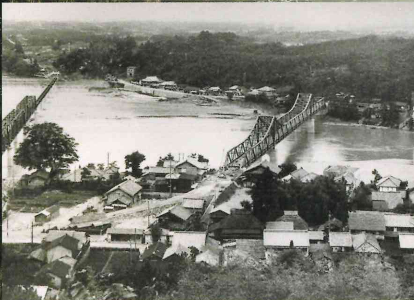
▲鳥羽山より俯瞰する鹿島橋(昭和10年代)
