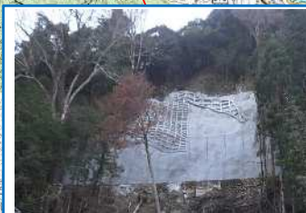
⑨(市)天竜両島高金線① 全面通行止め解除 R6年7月31日解除
