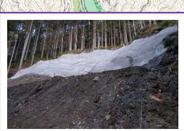
⑦(一)熊小松天竜川停車場線 ④ 上部吹付工施工完了 R7年3月末解除予定
