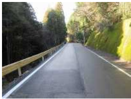
②(主)天竜東栄線(枇杷橋) 片側交互通行解除 R7年1月20日解除
