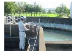
薬品注入に関する実証実験 (令和6年度)〈浄水機能の強化〉 [大原浄水場]
