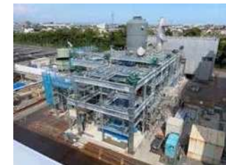
エネルギー効率の高い汚泥焼却炉への更新工事 （令和2～6年度）[中部浄化センター]
