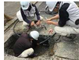
実地研修（管路修繕）
