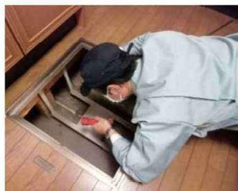
「土台・床組、基礎」調査の様子
