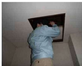
「小屋組・梁」調査の様子
