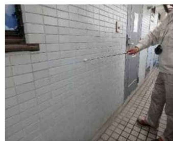
「外部（外壁）」調査の様子
