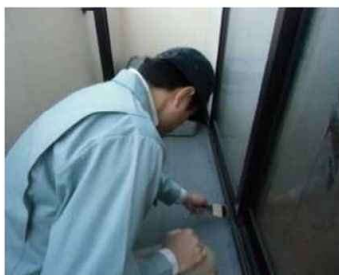
「外部（バルコニー）」調査の様子
