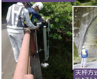
ロボットカメラによる橋梁点検
