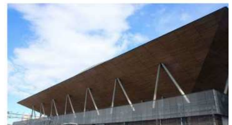
(天電材が使用された有明体競技場)
