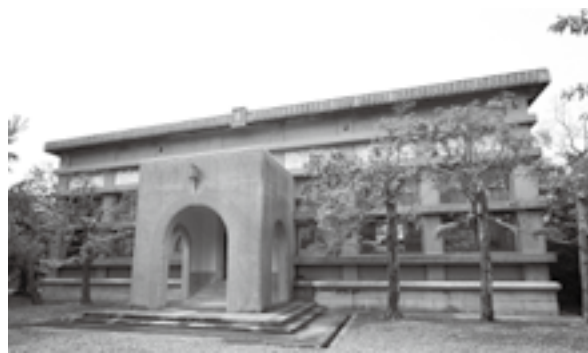
上下水道部住吉庁舎(中央区住吉五丁目)敷地内にある旧住吉浄水場ポンプ室
