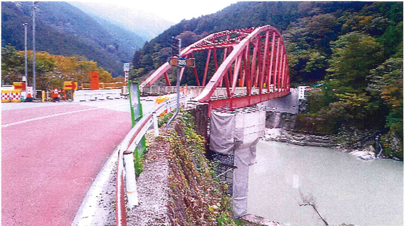
↑ 手前が天竜川左岸・佐久間側 国道152号 大輪橋の工事中
