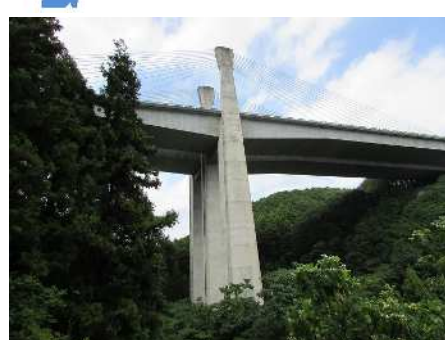
新東名高速道路 都田川橋
